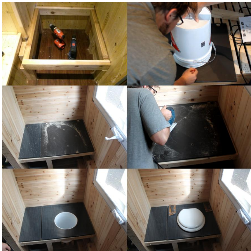
Étapes de la construction d'une toilette au compost (système à seau)
